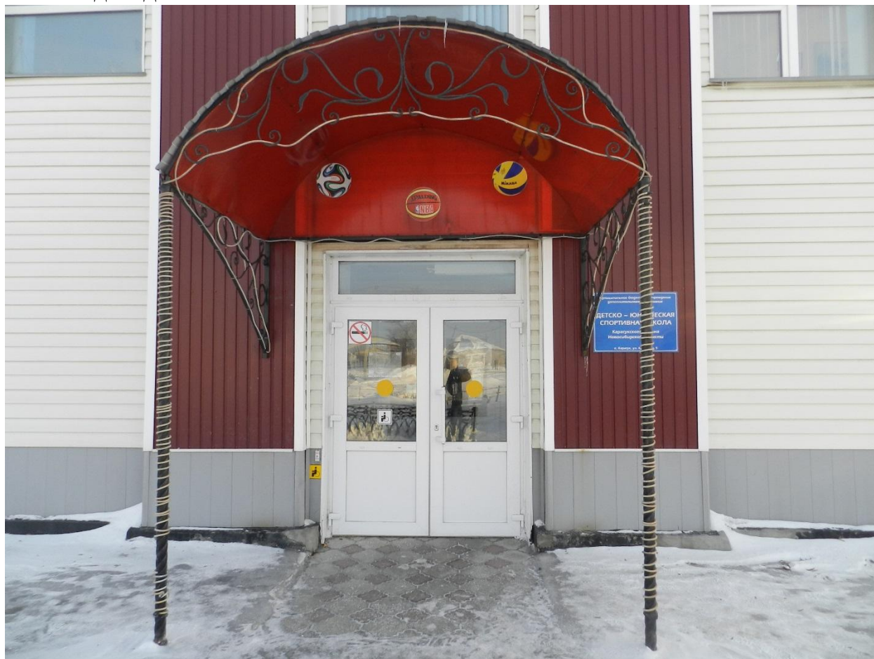
№3 Вход в здание
